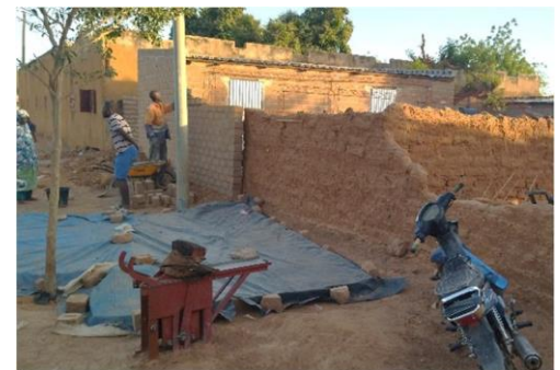
Bausteinproduktion. Neues Haus entsteht neben dem alten.
